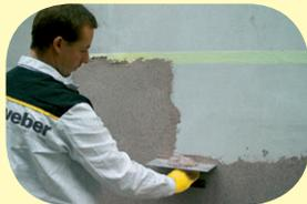
Dekoratívni omítka se nanáší nerezovým hladítkem v minimální síle vrstvy tak, aby byl podklad zrný omítky stejnoměrně dokonale zakrytý. **Ucelené plochy provádět bez přerušování a pouze z jedné výrobní šarže** viz odstavec upozornění.
