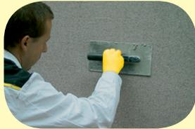
Vyhlázení se provádí opět nerezovým hladítkem ihned po nanesení, ještě před zavadnutím dekorativní omítky. Nářadí je nutno průběžně umývat čistou vodou a následně otřít. Mokrě hladítko zanechá na upravované ploše po zatschnutí viditelné stopy.
