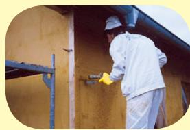
Omítka **webertop** se provádí klasicky ostrým náhozem lící nebo strojně ve vrstvě 10–11 mm. Omítka se **nesmí** aplikovat natahováním hladítkem, **webertop** aplikujeme pouze náhozem nebo strojně. Podklad musí být navlhčen – ale voda při vlhčení nesmí stékat po fasádě.
