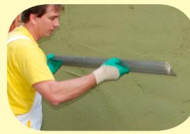
Omítka se ihned po nastříkání na zeď stahuje zubatým hladítkem. Velmi důležitá operace pro vytačení vzduchových bublin z omítky.
