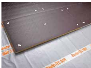
Upevnění okrajů (lineární upevnění)
