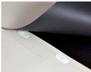
Upevnění okrajů (lineární upevnění)
