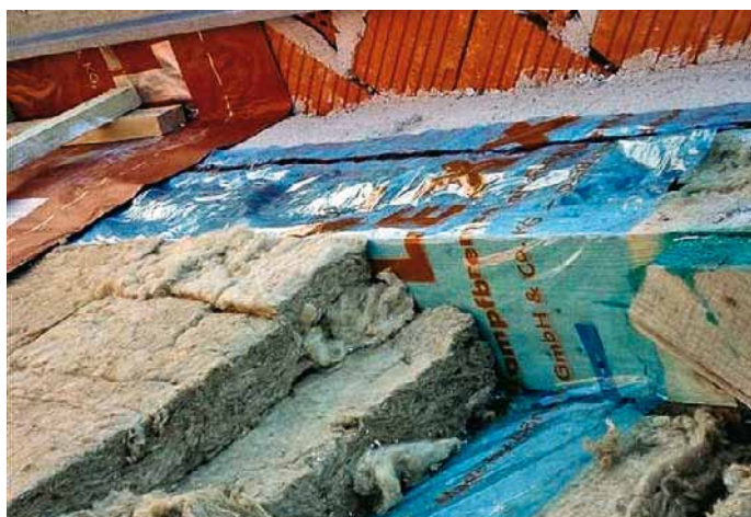
Obr. 4: Vzduchotěsné napojení fólie DELTA®-Sd FLEXX na přilehlou stavební konstrukci
