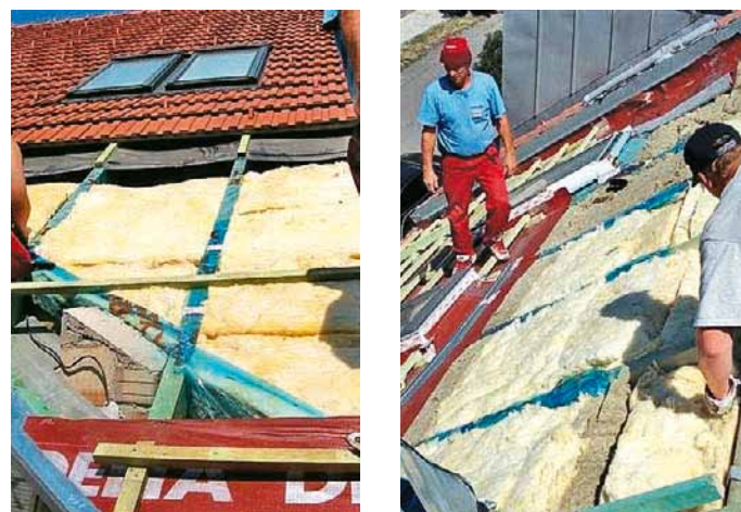
Obr. 5, 6: Doplnění tepelné izolace na plnou výšku krokvi
