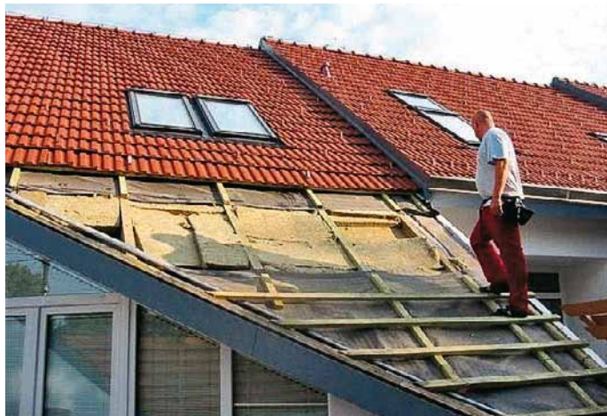
Obr. 2: Demontáž původních, chybně provedených vrstev šikmé střechy
