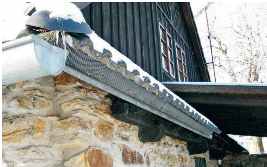
Tahokov Rheinzink je dobře tvarovatelný i lépe průvzdušný než plast
