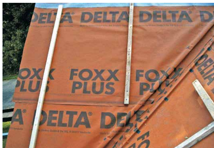
Vodotěsné provedené úžlabí je nezbytné
