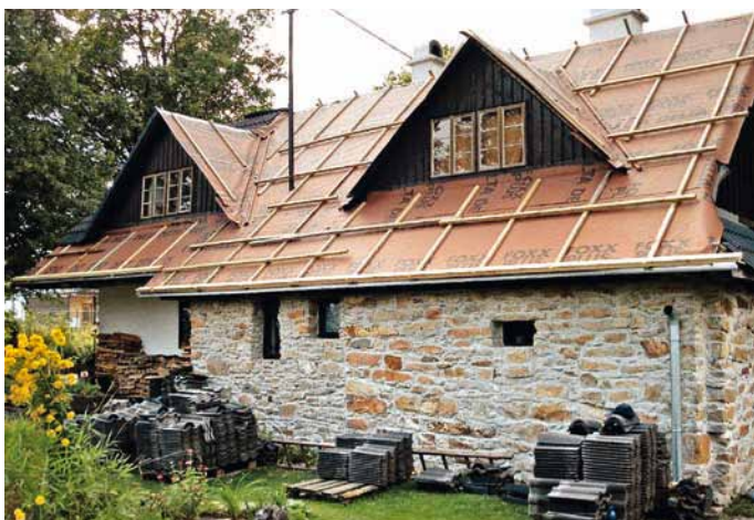
DELTA FOXX PLUS na střeše se sklonem 40° v horské oblasti je ideálním technickým řešením
