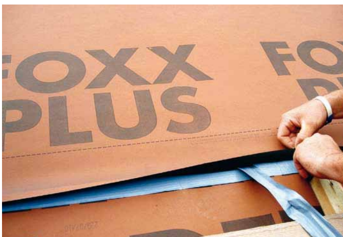
Patentovaný vodotěsný systém slepování pásů fólie DELTA FOXX PLUS – lepidlo na lepidlo
