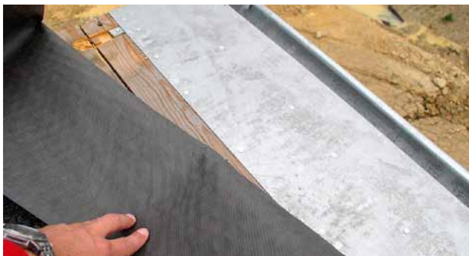
Obr. 5: Detail zakončení strukturní dělicí vrstvy na okapové hraně
