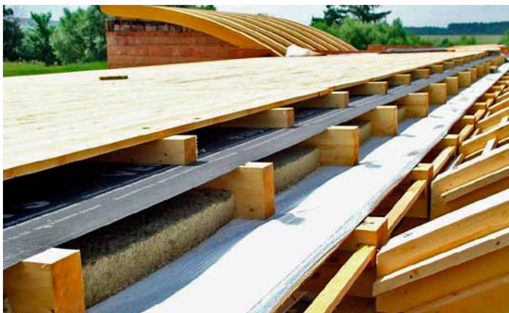
Obr. 1: Skladba střešního pláště – dřevěné bednění těsně před položením strukturní dělicí vrstvy DELTA-TRELA
