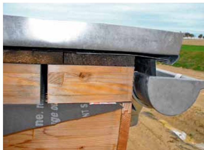
Obr. 3: Detail okapnice – falcovaná plechová krytina, strukturní dělicí vrstva, zatahovací plech, dřevěné bednění, větraná mezera, pojistná hydroizolace, konstrukce krovy
