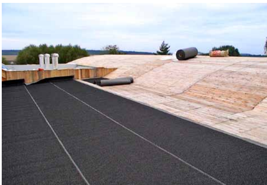
Obr. 4: Strukturní dělicí vrstva chrání bednění před vlhkostí během pokládky i po položení krytiny
