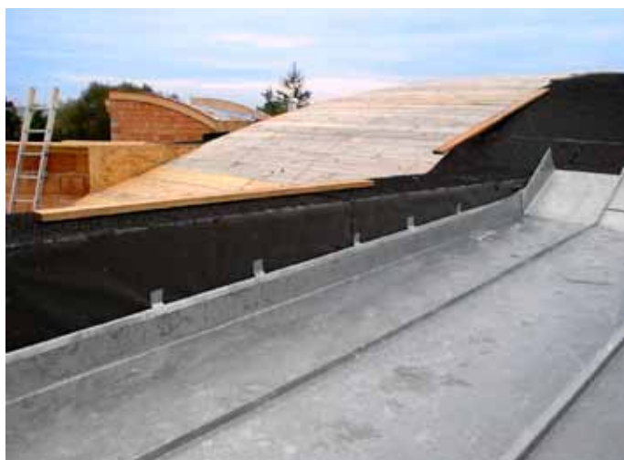
Obr. 2: Strukturní dělicí vrstva DELTA-TRELA je ideální podklad pod falcovanou plechovou krytinu a ochrana pro bednění
