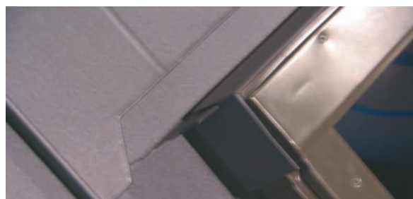
Osazení zadní části oplechování z hladkého plechu a uchycení třetí šablony zaháknutím o toto oplechování.
