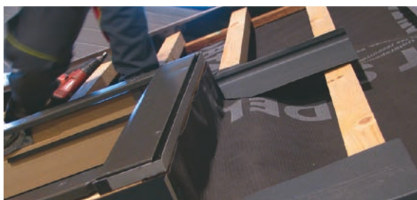
Osazení zadní části oplechování z hladkého plechu a uchycení třetí šablony zaháknutím o toto oplechování.
