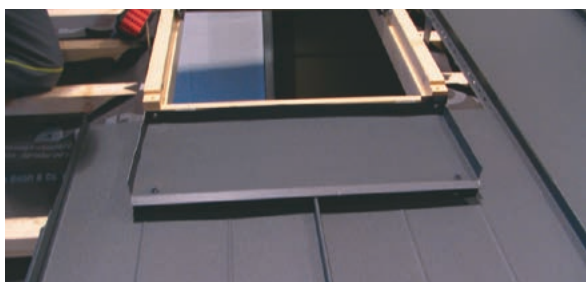
Zhotovení čelového oplechování z hladkého plechu a jeho přichycení k větracím profilům a oknu. Osazení druhé boční šablony, vytvarované do potřebného tvaru.
