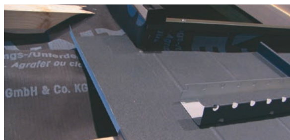
Osazení spodních šablon upravených do potřebného tvaru.
