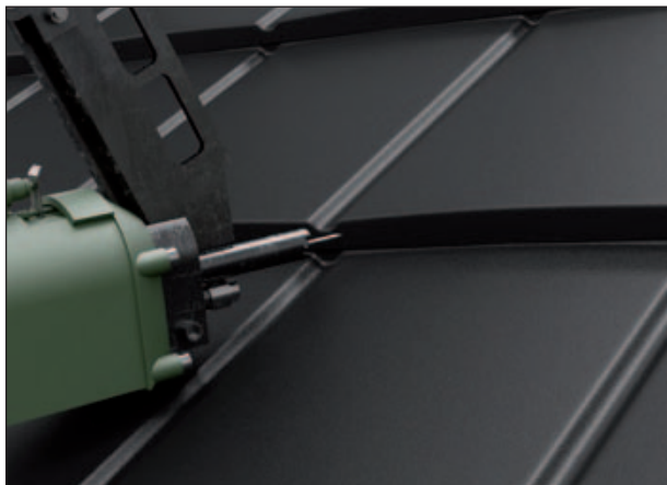
Vzdálenost šroubu od vodící drážky: 15 mm
